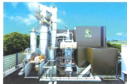
焼却プラント
