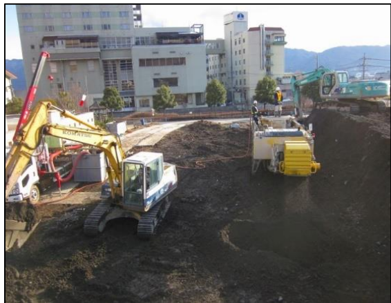
自走式土質改良機による無害化处理(不溶化)
