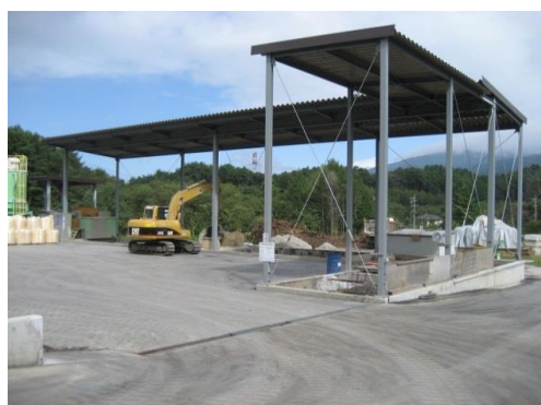
汚泥保管施設
